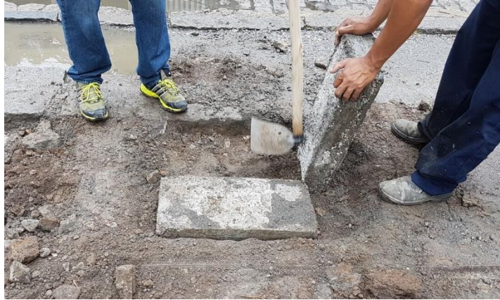
Figura 17 – Assentamento das placas para piso de concreto
