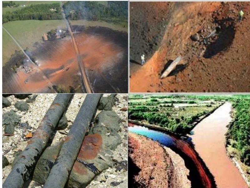
Figura 1.1: Falhas em dutos (Fonte: Internet)
