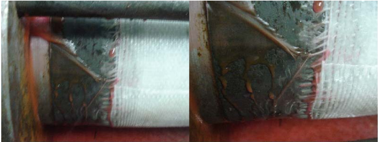
Figura 6.10: Vista detalhada da falha por delaminação
