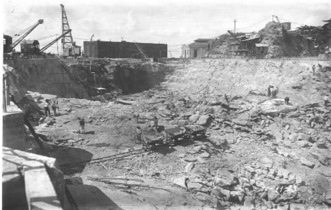
Figura 6 - Escavação para construção do Dique Alto. Régis
