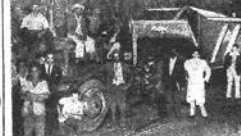
Desta vez, o morro de Santa Antônia vem mesmo abaixo. As obras de saneamento que serão feitas...
