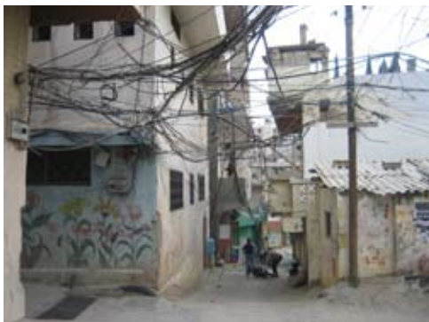
Figure 6: Rue à l'intérieur du camp de Beddawi.
