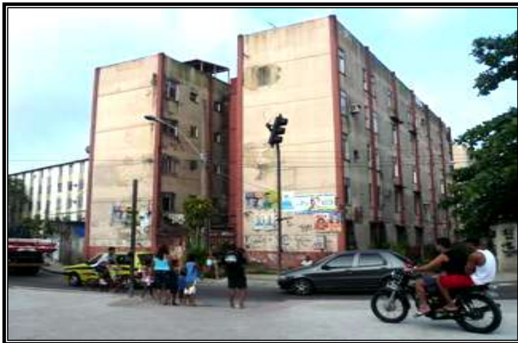
Figura 28 - Na parte interna do complexo de prédios, o trânsito de moradores, mistura-se ao de veículos
