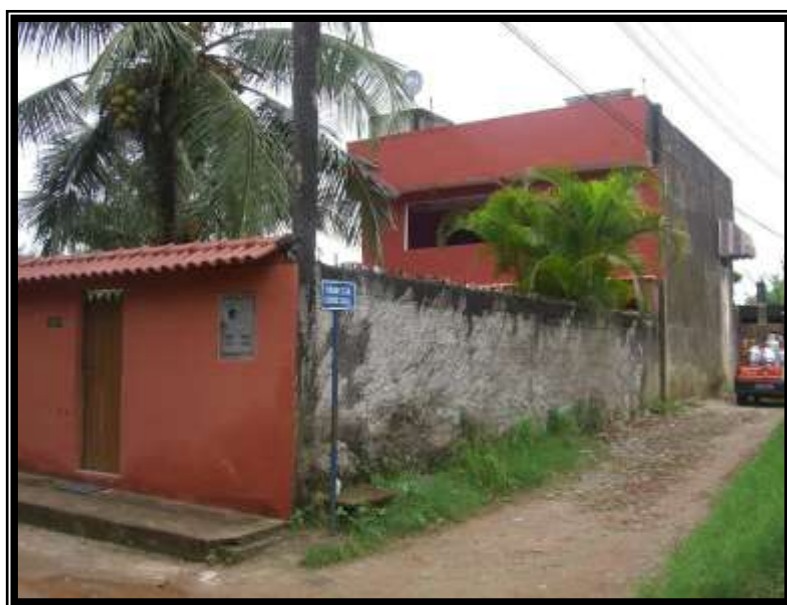
Figura 17 - Casa situada à Rua Moisés, também na parte Central do bairro. Ao ser reformada incorporou o 2º pavimento, onde mora um dos filhos do proprietário. 98
