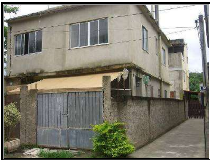
Figura 16 - Casa situada na Rua dos Evangelhos, parte “central” da Cidade de Deus. A arquitetura original foi inteiramente modificada.
