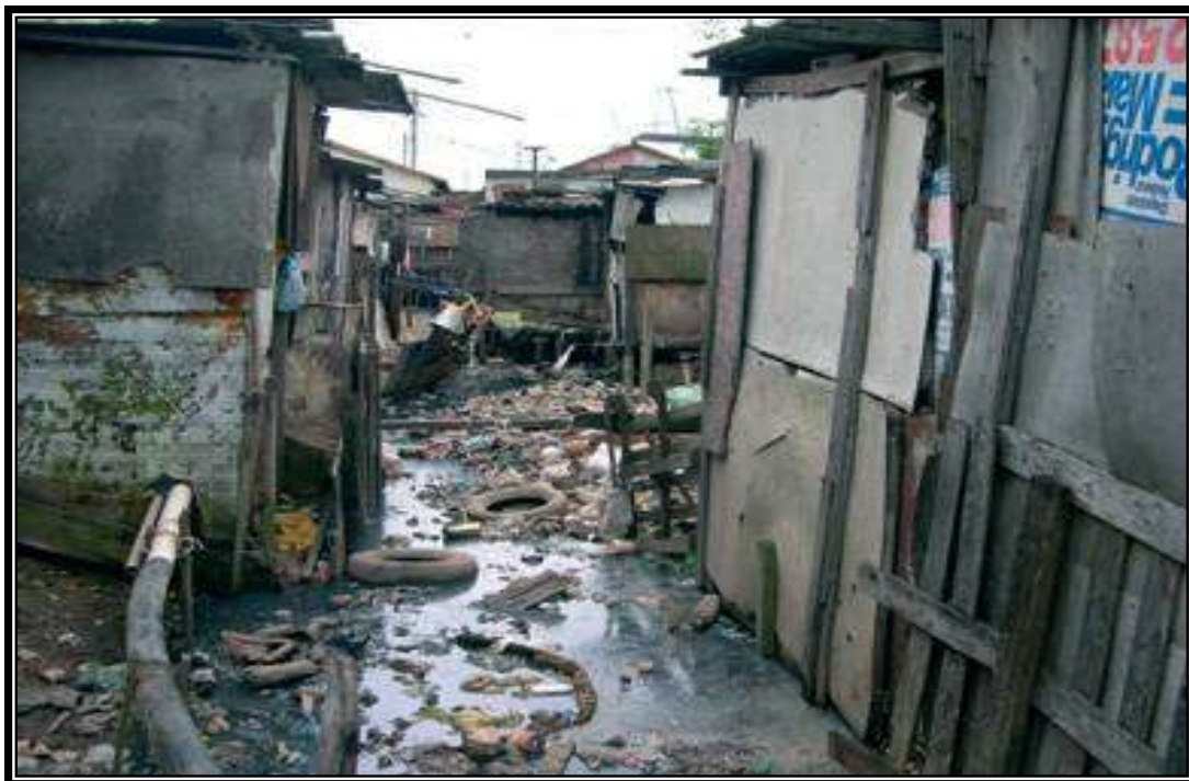
Figura 23 - Vista do interior das “Triagens”. A inexistência de ruas e oferta de serviços públicos é flagrante.
