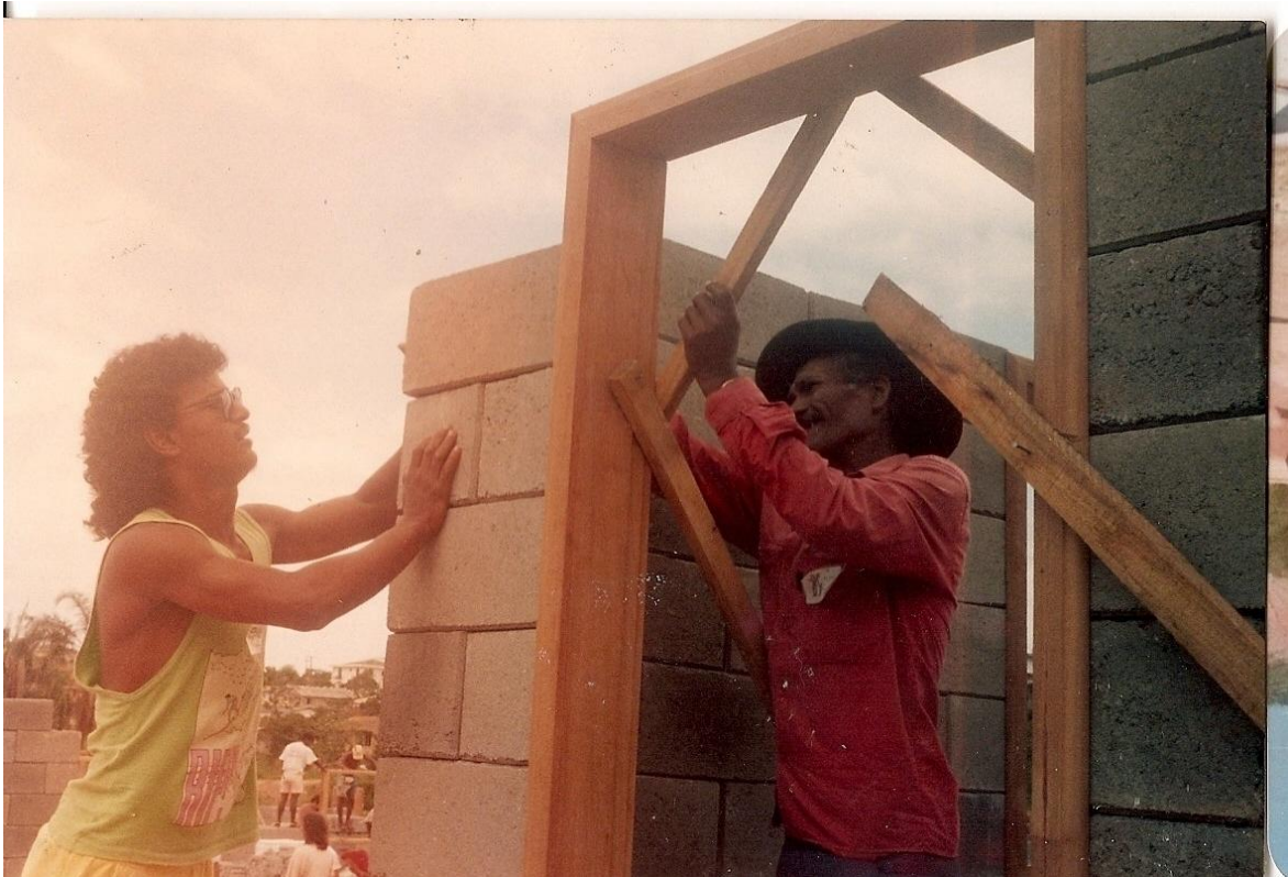
Foto 10 – O trabalho dos moradores no mutirão (1991 ou 1992)
