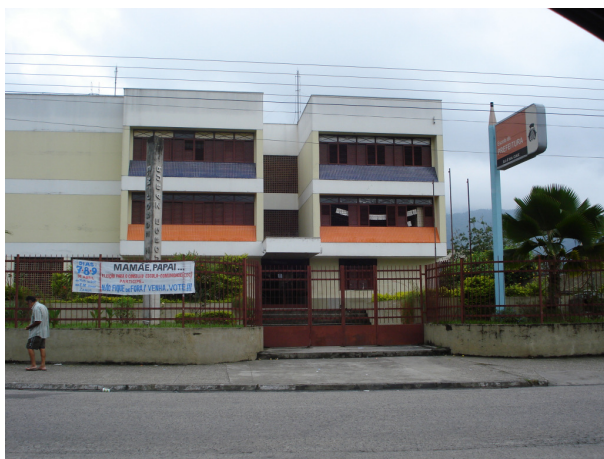
Figura 8 – Escola Municipal Jorge Zahrur, situada na segunda gleba. Fotografia de Gizele Avena, em abril de 2008.
