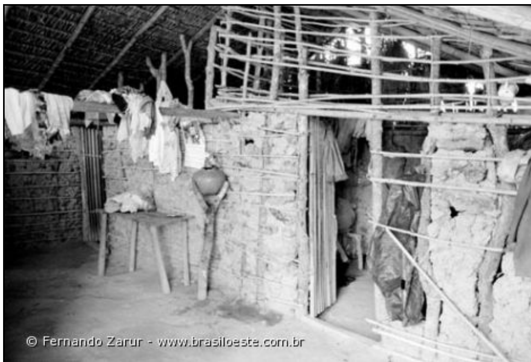
Figura 4 – Exemplo de habitação feita de barro (pau-a-pique) ( http://www.brasiloste.com.br )
