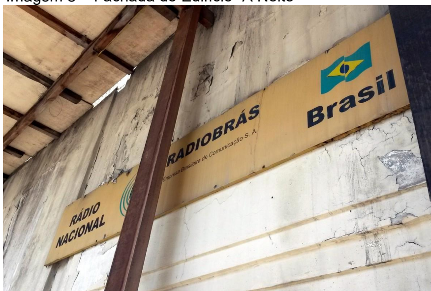
Imagem 8 – Fachada do Edifício “A Noite”
