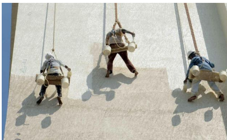
Figura 68: “Balancim”, equipamento específico para pintura de fachadas de prédio.
