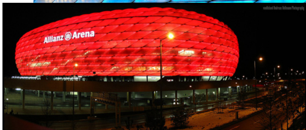
217 - Estádio Allianz Arena, projeto de Herzog e De Meuron. Possui parede externa de elementos moldados em policarbonato translúcido. O emprego de materiais plásticos de alta tecnologia permite a iluminação interna com luz do dia filtrada e efeitos estéticos impressionantes com a iluminação colorida noturna. Alemanha, 2005.
