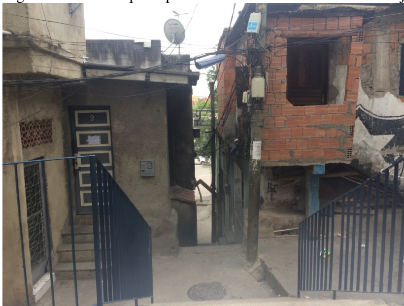
Figura 3 - Visão da principal entrada de acesso à Creche do Caju. Caju, RJ
