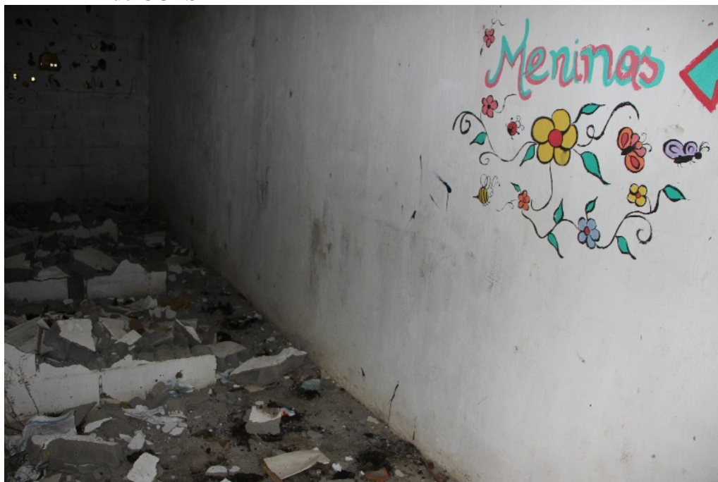
Figura 16 - Banheiro feminino do pavilhão que era ocupado pelo projeto Inaê, do GUESB
