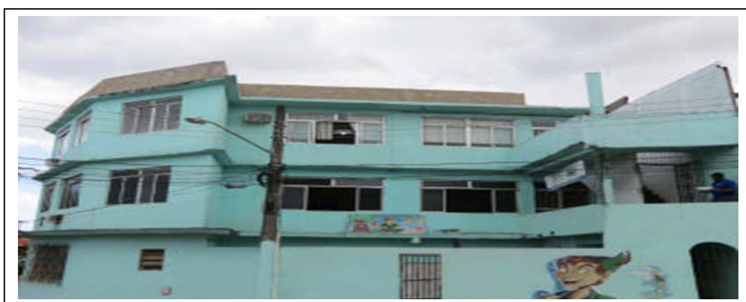
Figura 8 – Prédio da Associação de Moradores do Guarabú
